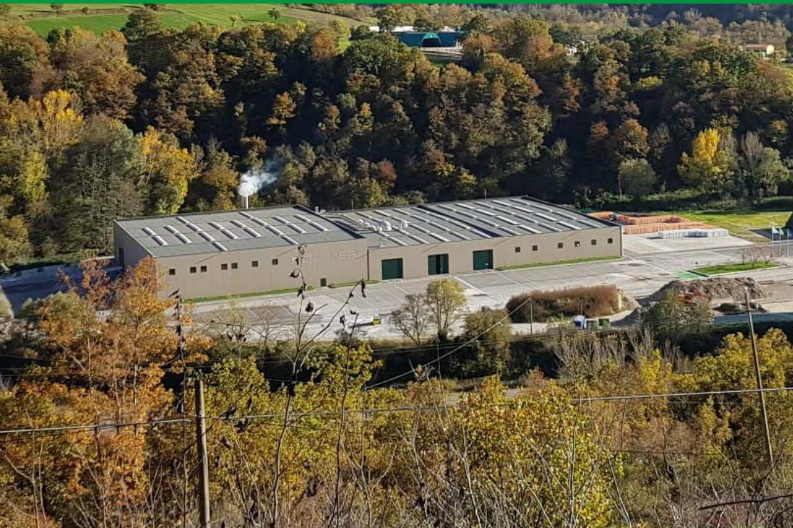
PLANT IN ARQUATA DEL TRONTO - ASCOLI PICENO
